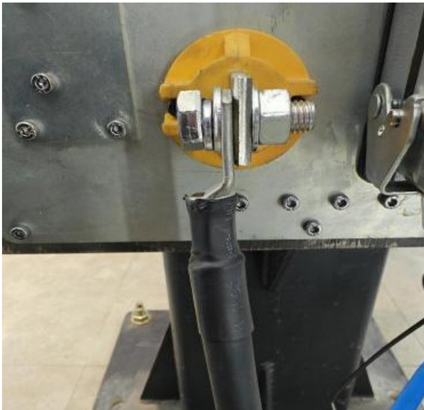
图 2-4 焊机正极线固定处
