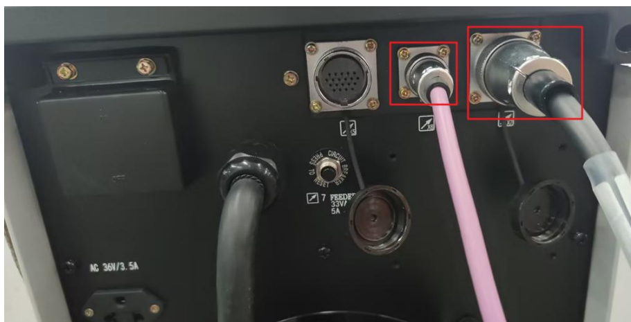
图 2-22 通讯线缆安装
