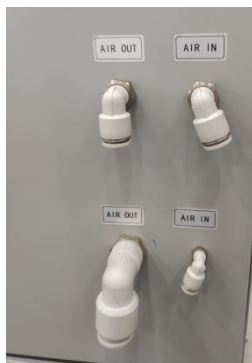
图 4.9.6 防爆柜气管接口
