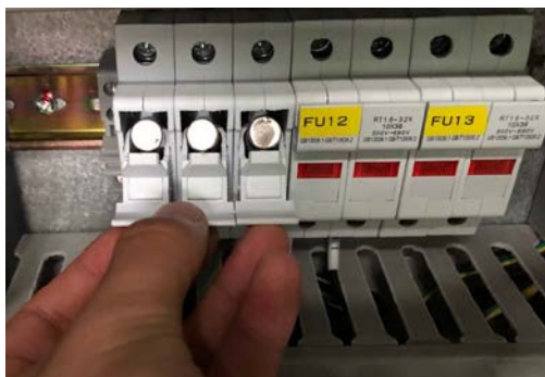
Figure80:Replacing fuses 更换熔断器
