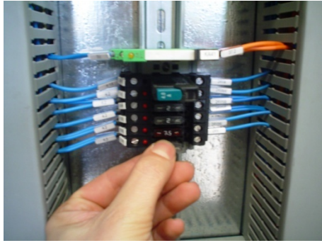
Figure81:Replacing fuses 更换熔断器
