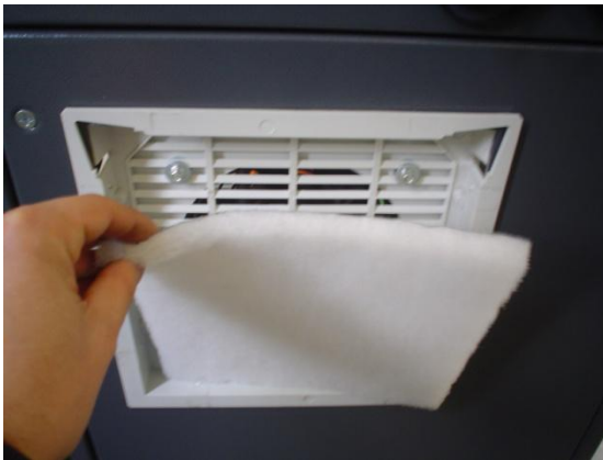
检查和更换除尘器步骤 3
